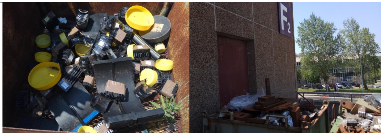
Desmontaje de objetos en las instalaciones de ISQ
